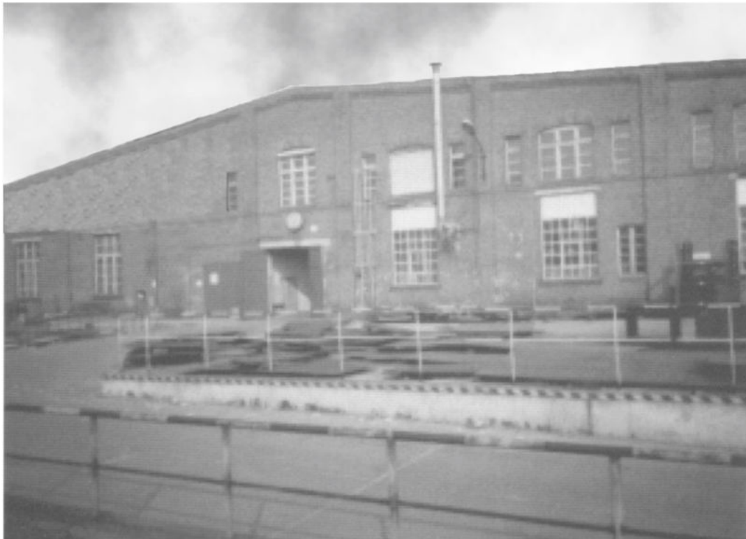
Gebäude der Gesellschaft für Luftfahrt in Teltow Oderstraße (Halle 21 GRW)
